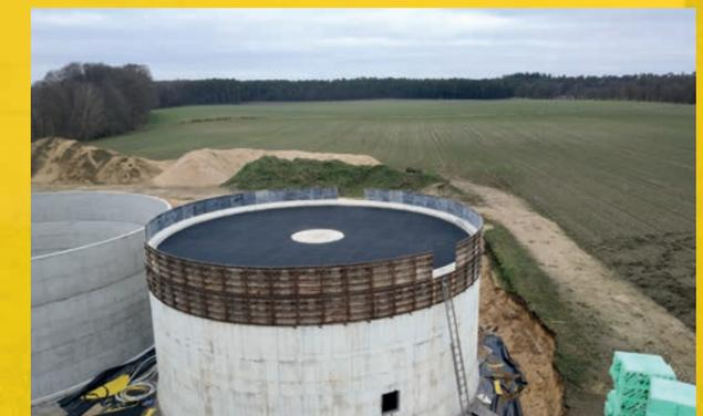
Betonschutz WireTarp für Betonbehälter mit Stahlbetondecke
