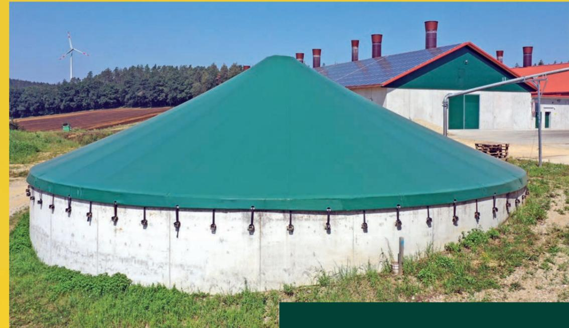
Behälterabdeckung mit Mittelstütze
