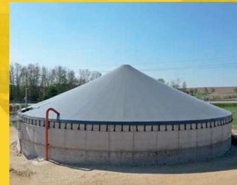
Behälterabdeckung mit Mittelstütze
