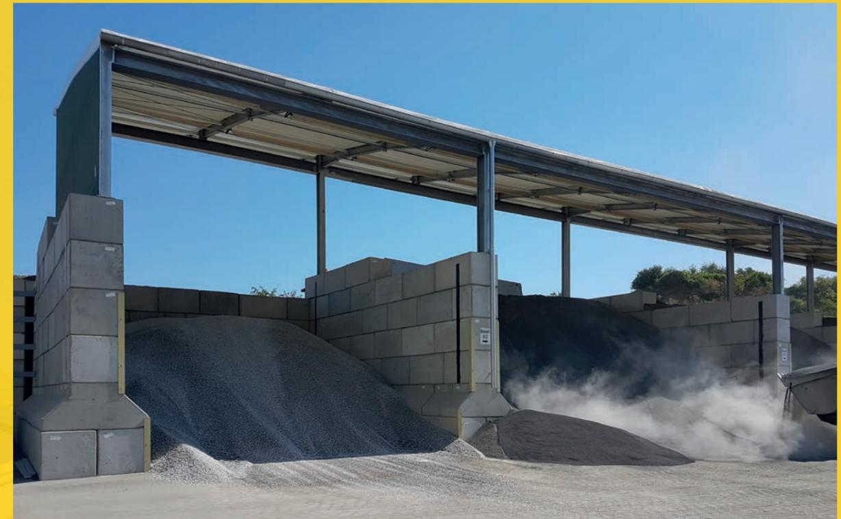
Boxenüberdachung mit Befüllungs- und Entnahmestationen
