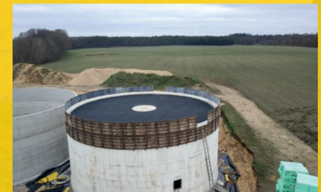
Protezione del calcestruzzo WireTarp per vasca in calcestruzzo con soffitto in cemento armato
