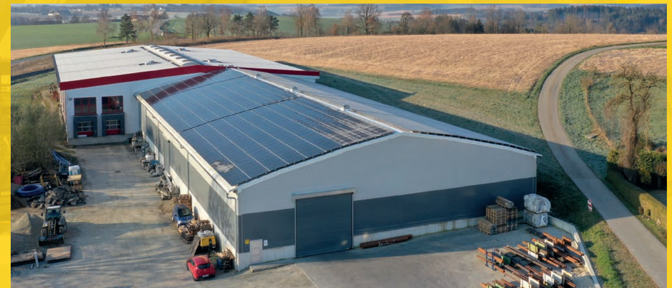
Magazzino spedizioni con impianto fotovoltaico
