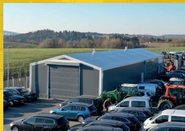
Capannone per trattamenti
