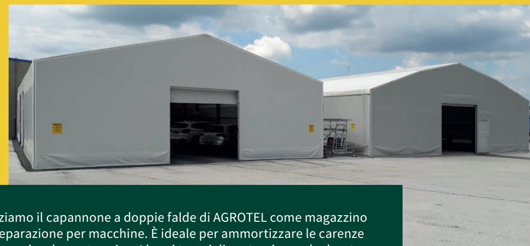
MAGAZZINO Dimensioni: L 20 m / L 12,2 m / A 5,27 m
