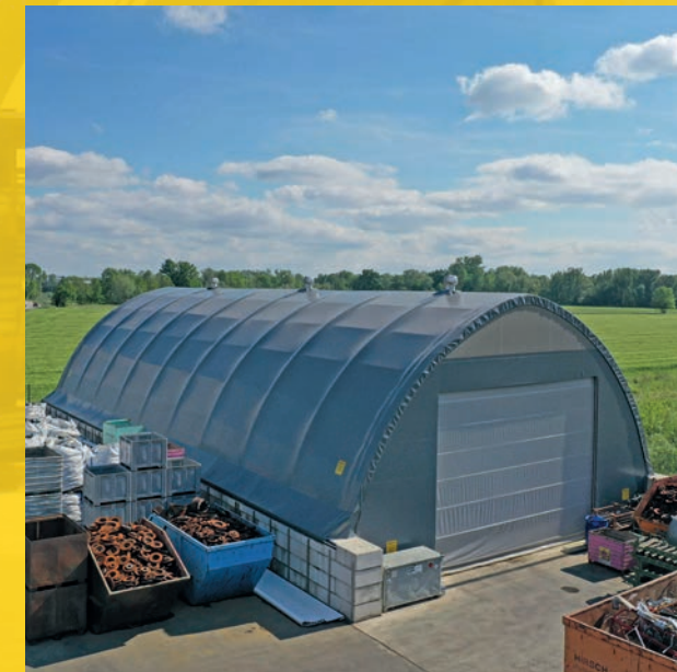
Struttura ad arco con travi in profilato d'acciaio come magazzino
