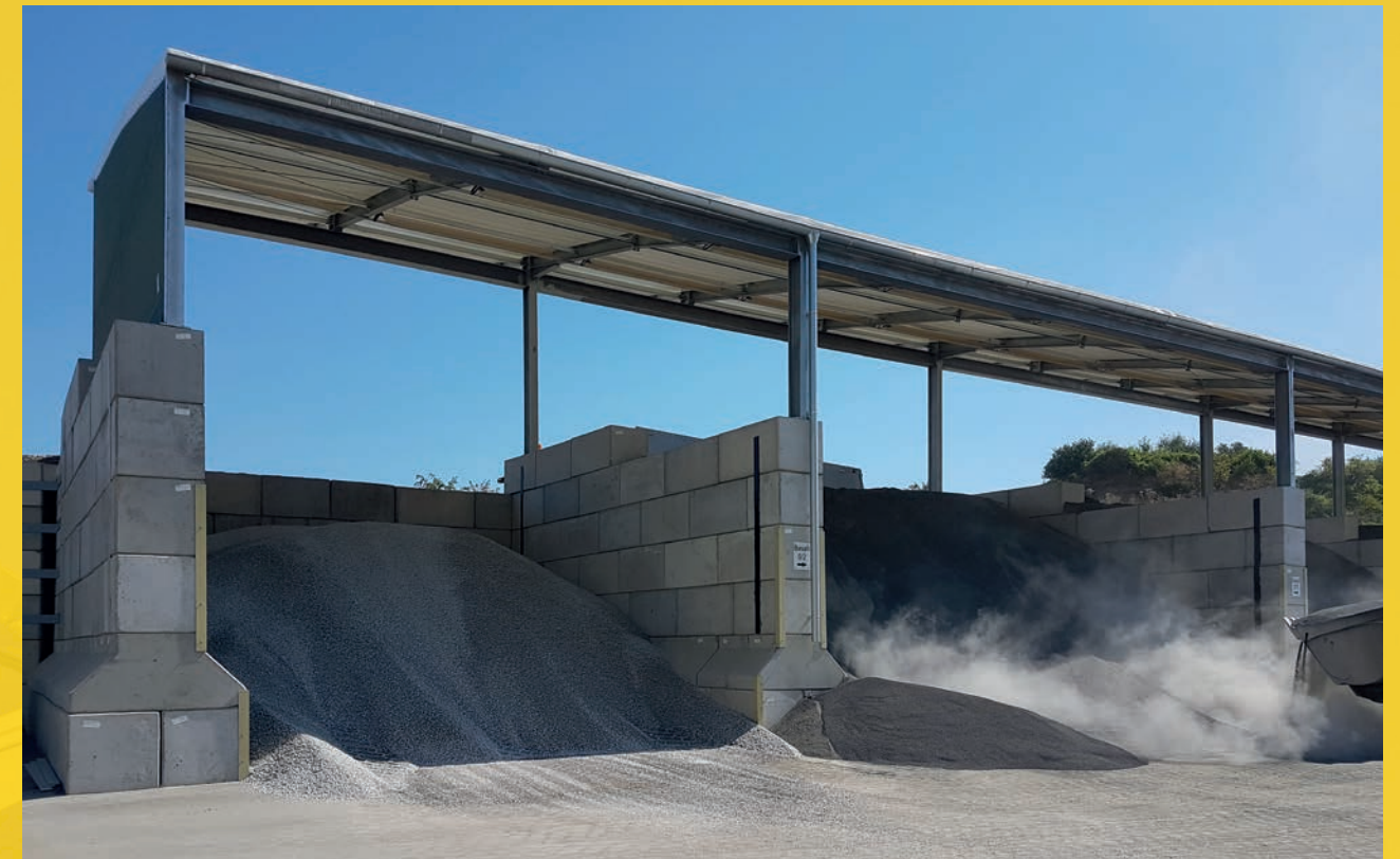
Copertura per baie di stoccaggio con stazioni di riempimento e rimozione
