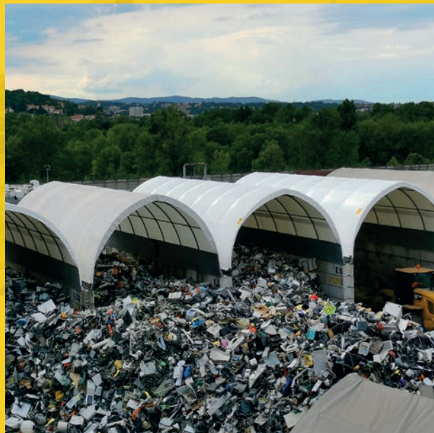
Copertura per Riciclaggi
