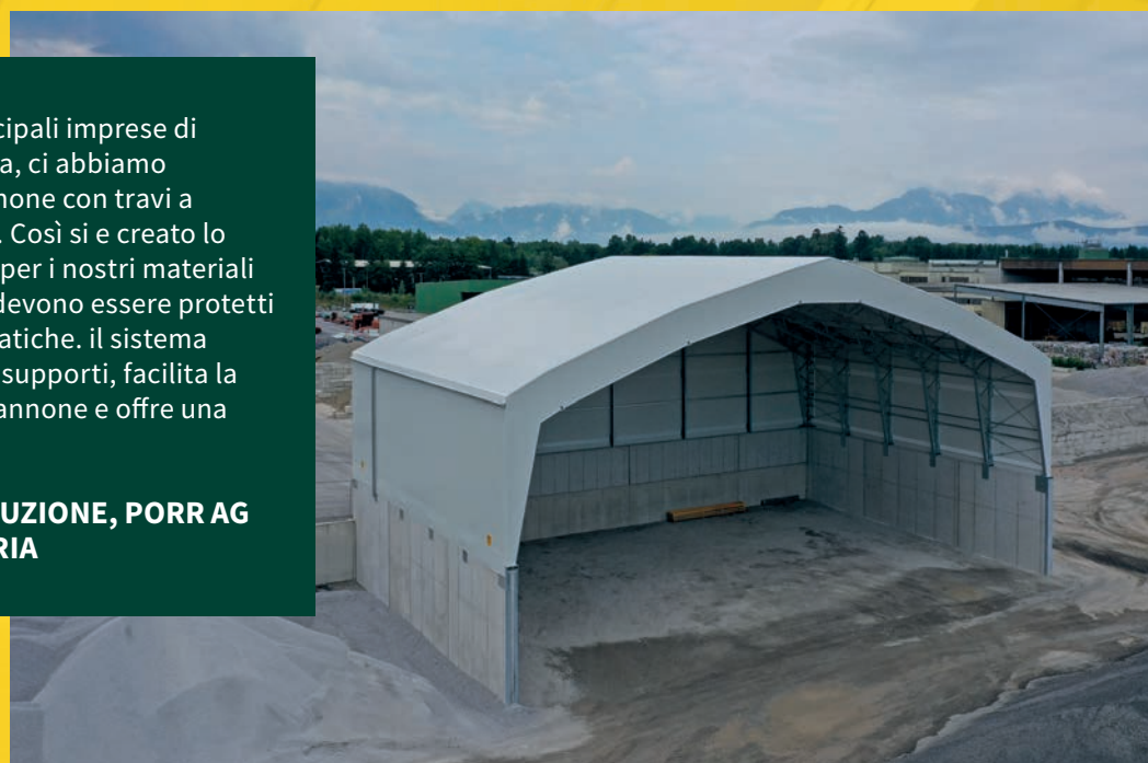
MAGAZZINO Dimensioni: L 18 m / L 30 m / A 15,15 m
