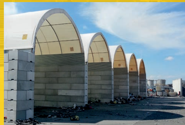
Copertura delle baie di stoccaggio
