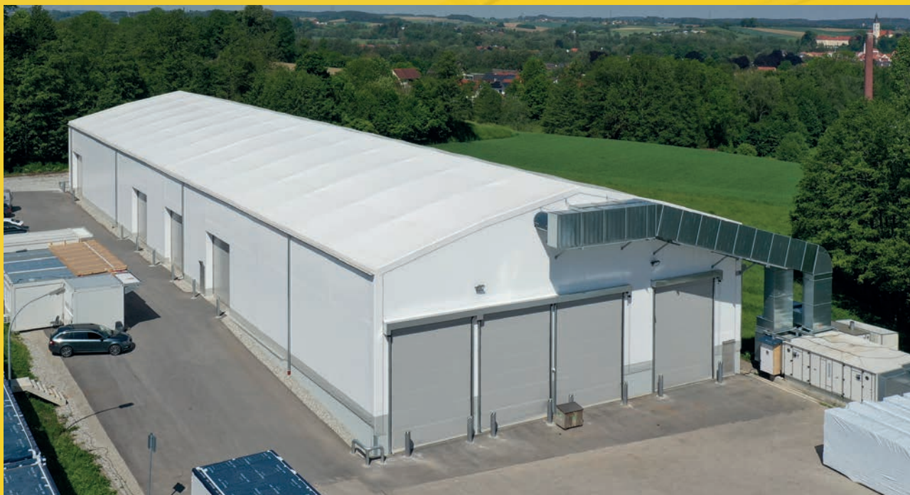
Capannone di produzione
