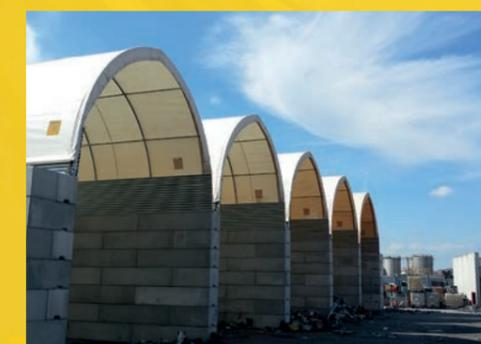
Struttura ad arco, copertura baie di stoccaggio
