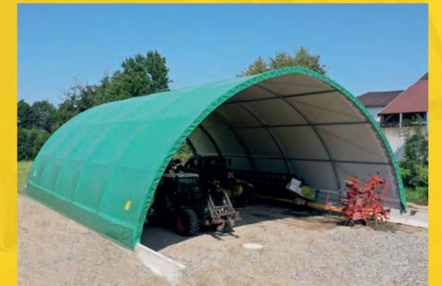
Struttura ad arco con travi in profilato d'acciaio come sala macchine
