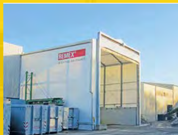
Capannone di riciclaggio
