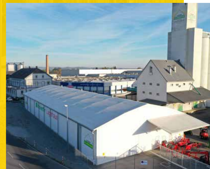
Capannone di stoccaggio
