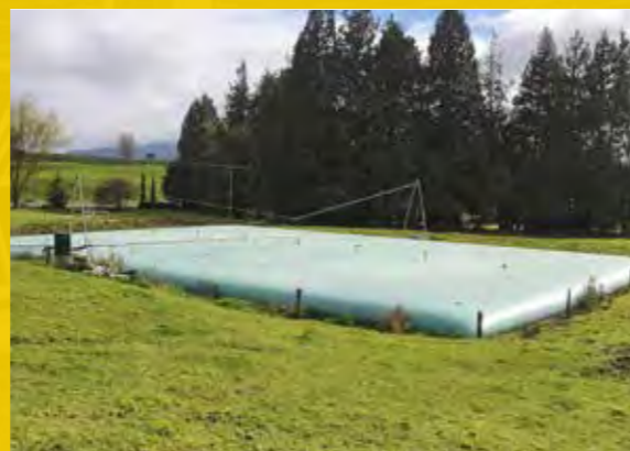
Serbatoio per le acque reflue
