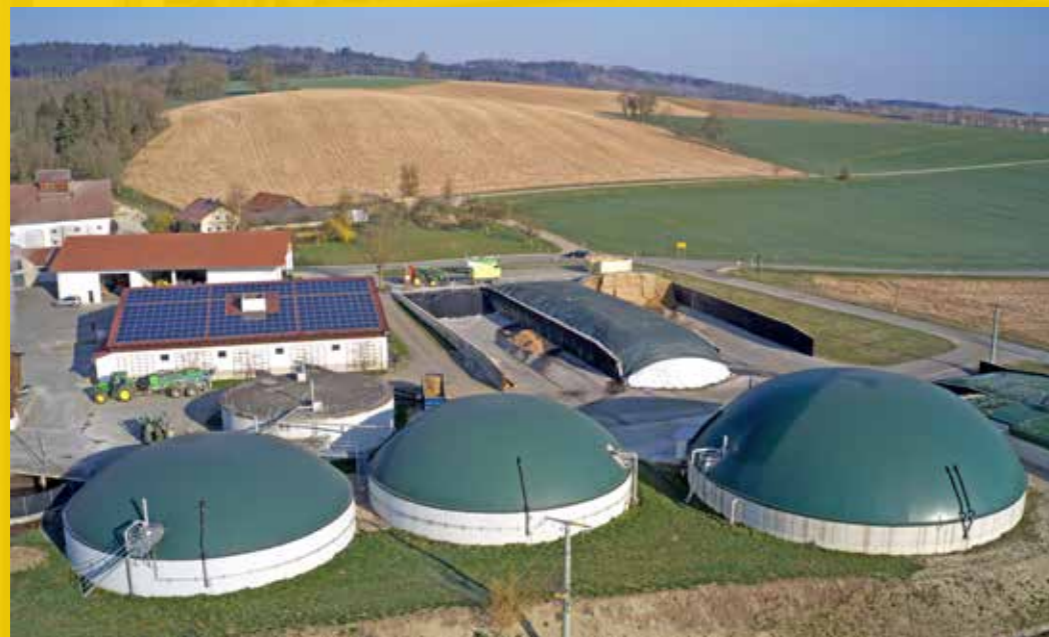
IMPIANTO DI BIOGAS
