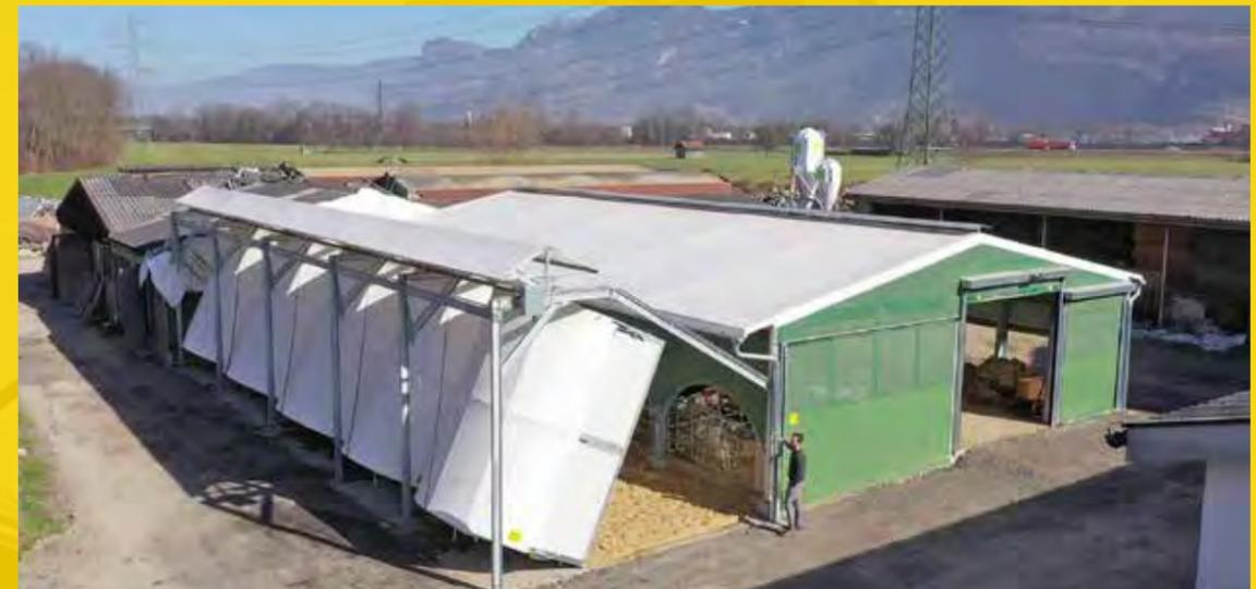
Einfaches Entmisten durch patentierte Kippfunktion
