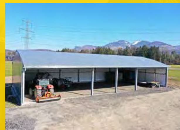
Capannone sala macchine
