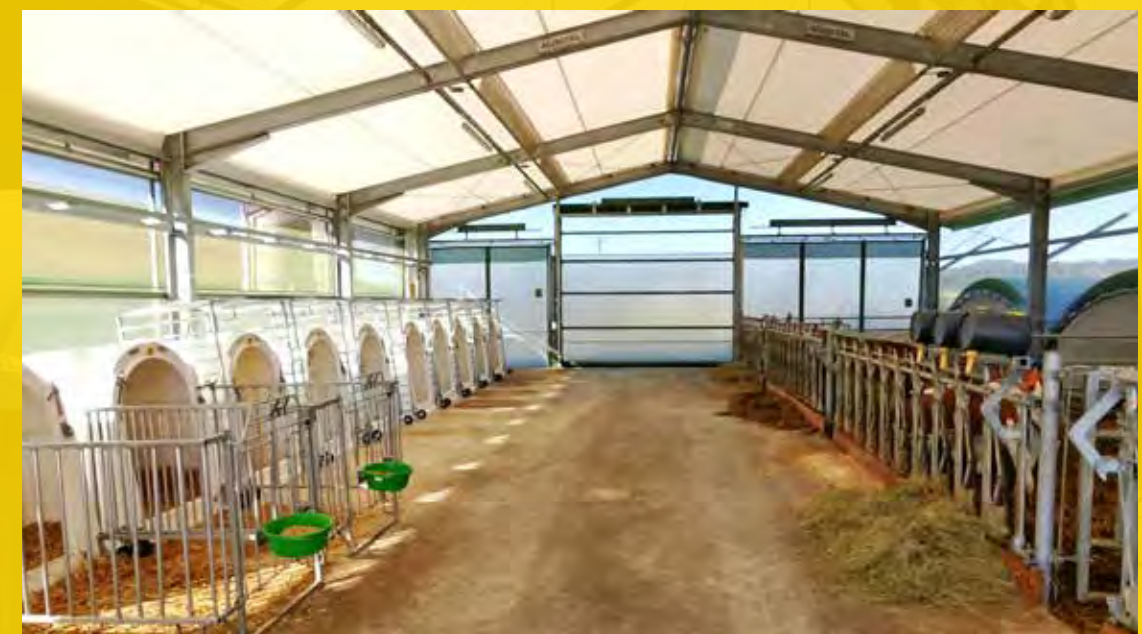
Controllo della ventilazione attraverso sistemi frangivento laterali e portoni in telo
