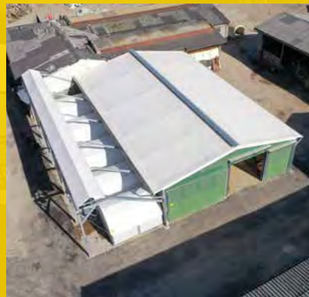
Luce piacevole attraverso la copertura del tetto bianco
