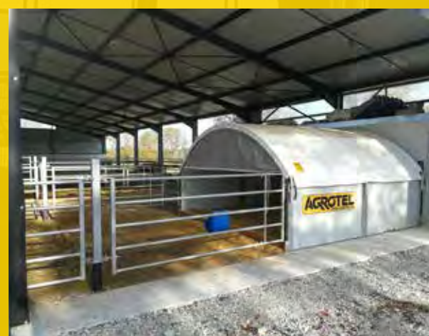
Igloo di gruppo come modulo singolo in un edificio esistente
