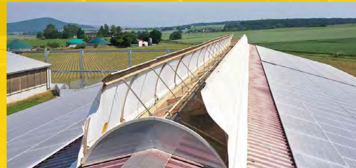
Licht- und Lüftungsfirst als optimale Ergänzung des Klimakonzepts
