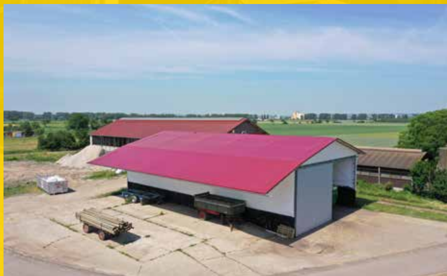
Futterlager mit Vordach
