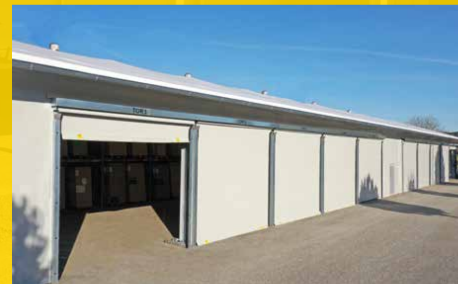
Maschinenhalle mit Toren
