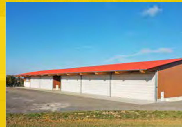
Falttore an Maschinenhalle
