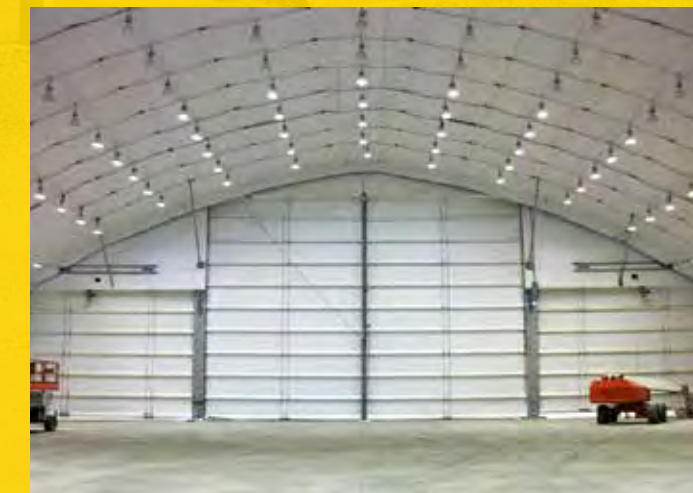
Maschinenhalle mit Innenmembran
