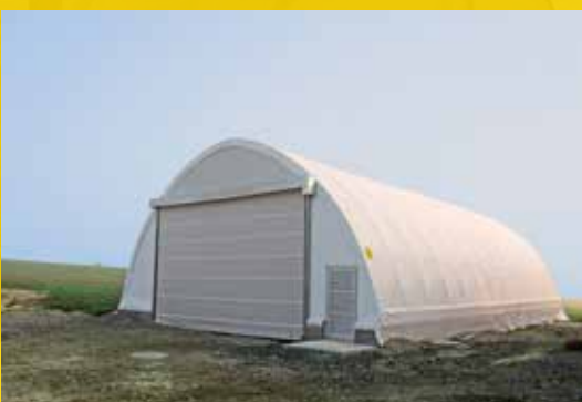
Bogenhalle mit Big-Rippen-Rolltor
