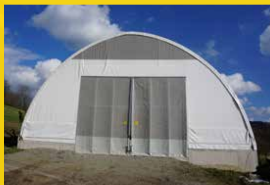
Bogenhalle mit Schiebetor
