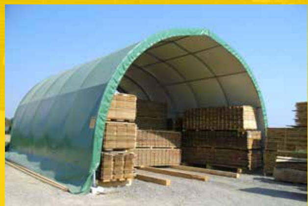
Rundrohrbogenhalle als Holzlager
