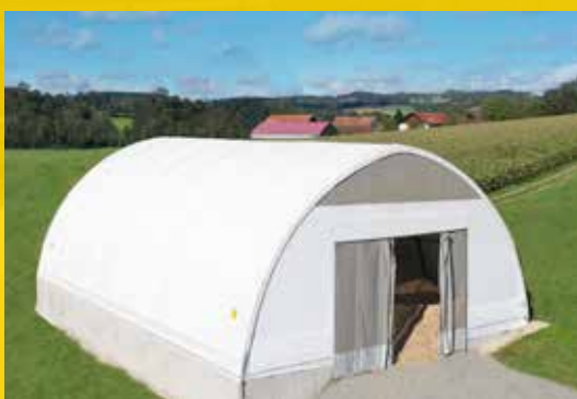
Bogenhalle als Hackschnitzellager
