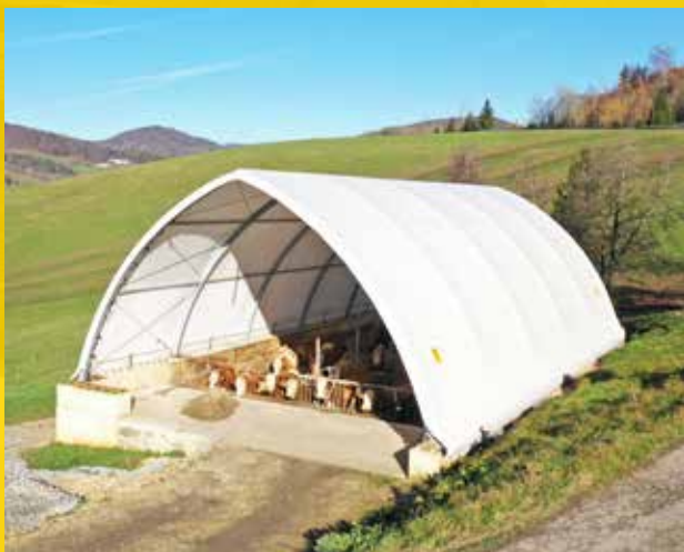
Profilträgerbogenhalle als Rinderstall
