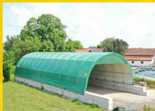
Bogenhalle auf Betonblocksteinen
