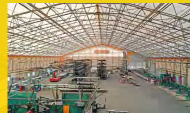
Construction métallique interne
