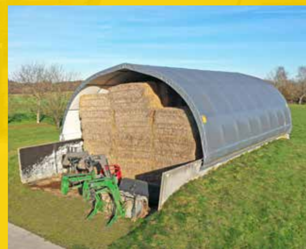
Construction sur silo - stockage de foin
