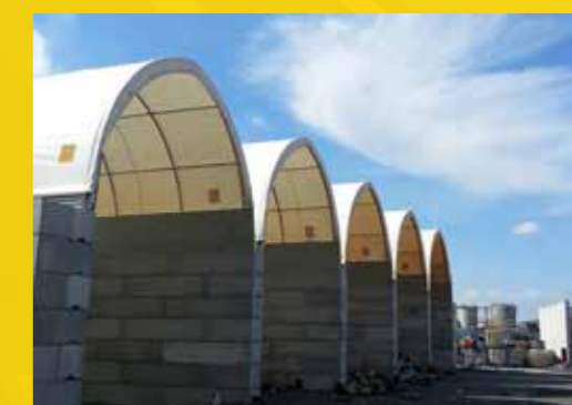
Tunnel sur box
