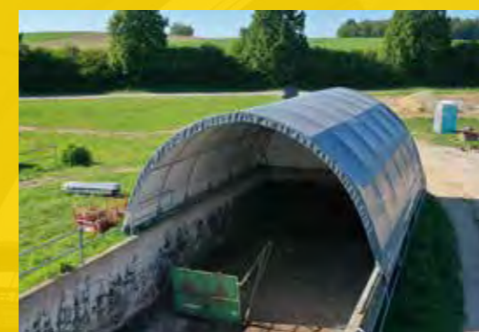
Tunnel sur silo
