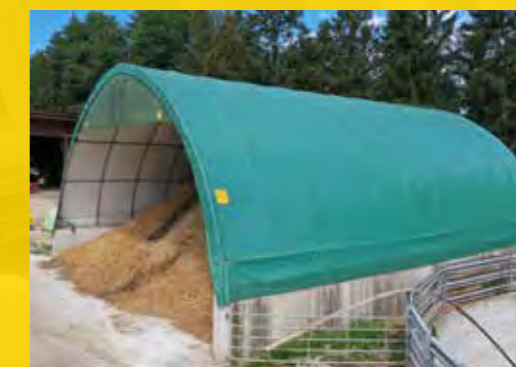
Tunnel sur mur en béton
