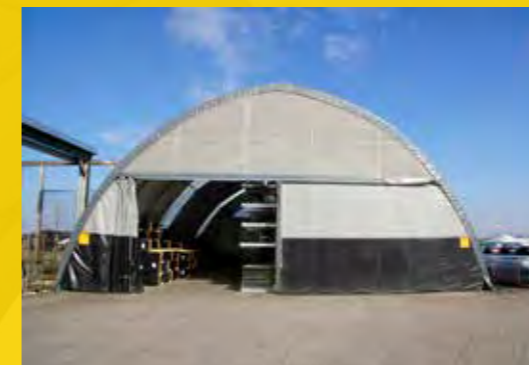
Tunnel avec porte coulissante et pignon 1/4
