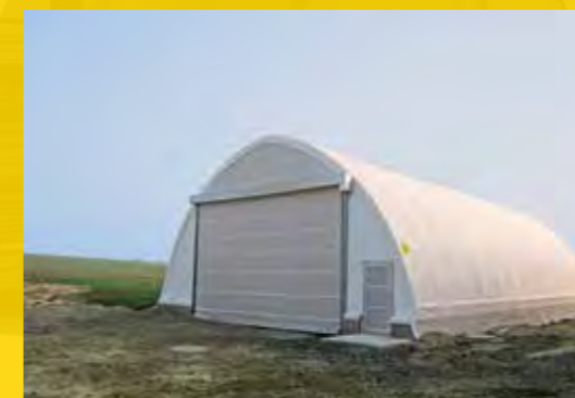
Tunnel avec grande porte à enroulement renforcé
