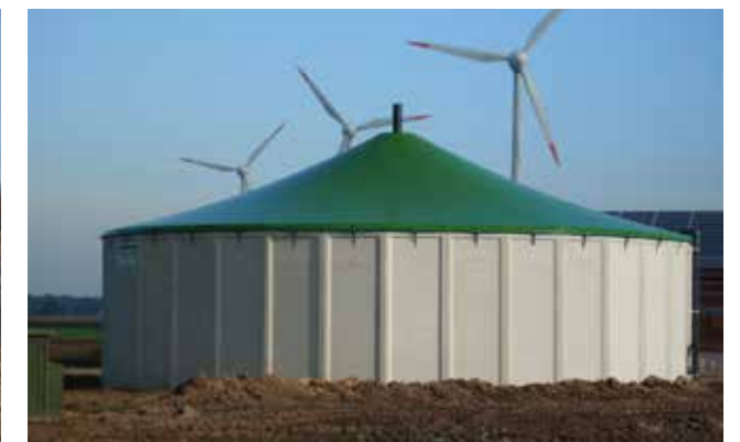
Biogasdach auf Betonfertigteilebehälter
