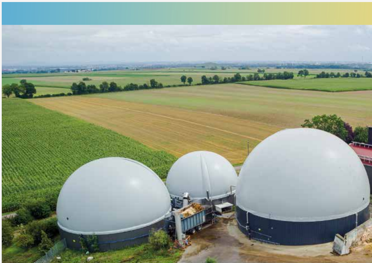
Drei DMGS mit Airflow-System 550 m³, 1210 m³ und 2590 m³ Speichervolumen
