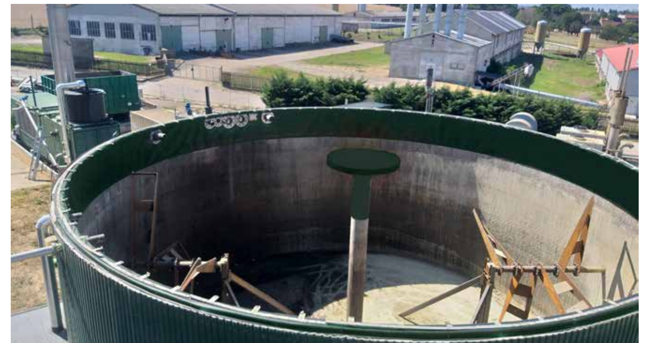
Wandsanierung 1 m mit Wanddurchdringungen
