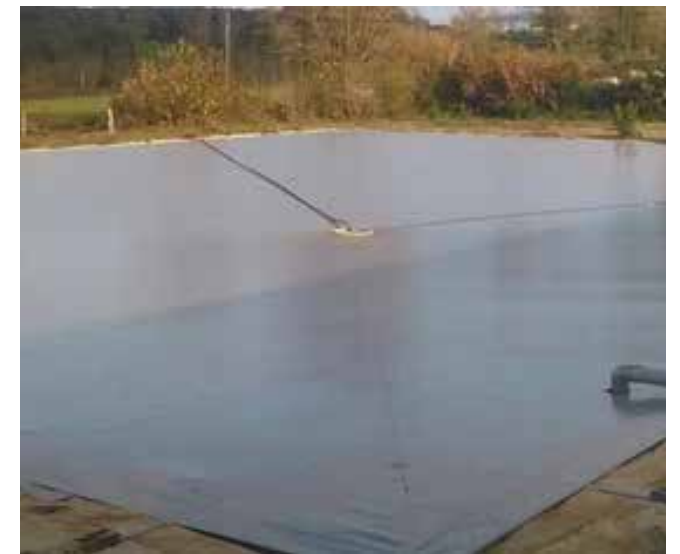
Freigespannte textile Abdeckung
