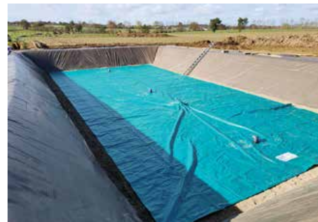
Flüssigdüngerreservoir mit Auffangwanne
