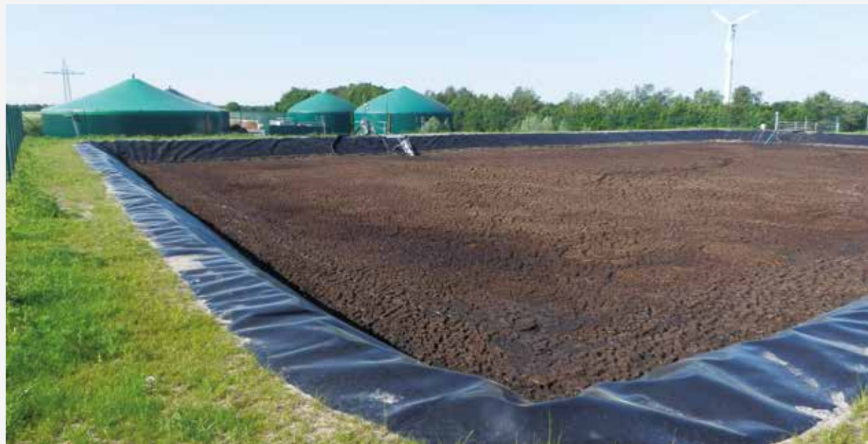
Gärrestesubstratlager 8400 m 3
