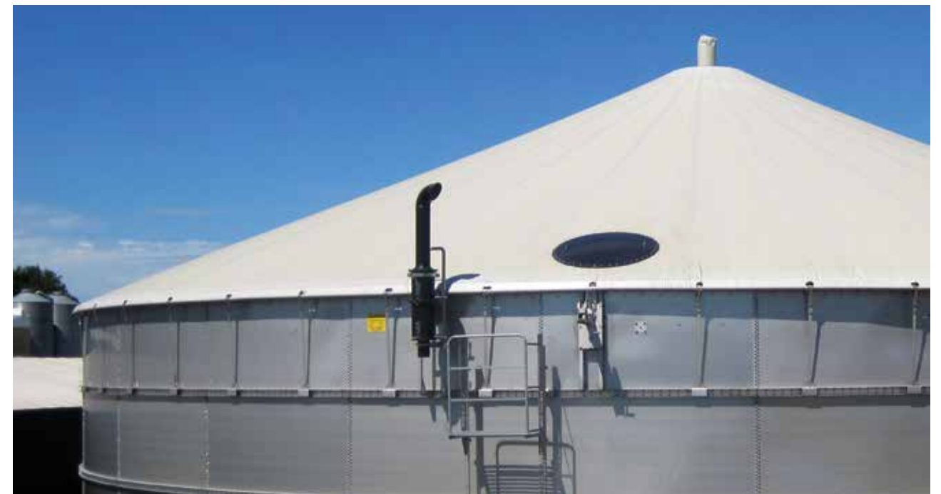
Biogasdach auf Edelstahlbehälter
