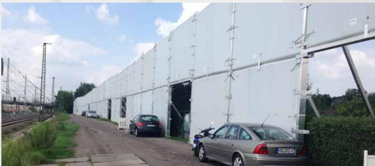
Mobiler Lärmschutz an einer Bahnstrecke: effektive Abschirmung für Anwohner und Bauarbeiten.
