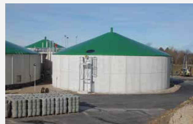
Biogasdach auf Stahlbetonbehälter
