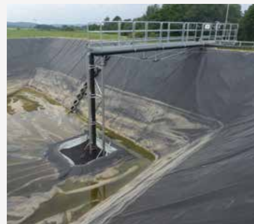
Lagune mit schwimmender Emissionsschutzabdeckung 9.300 m 3
