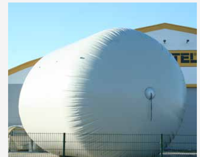
Zylinder-Gasspeicher 5.000 m 3
