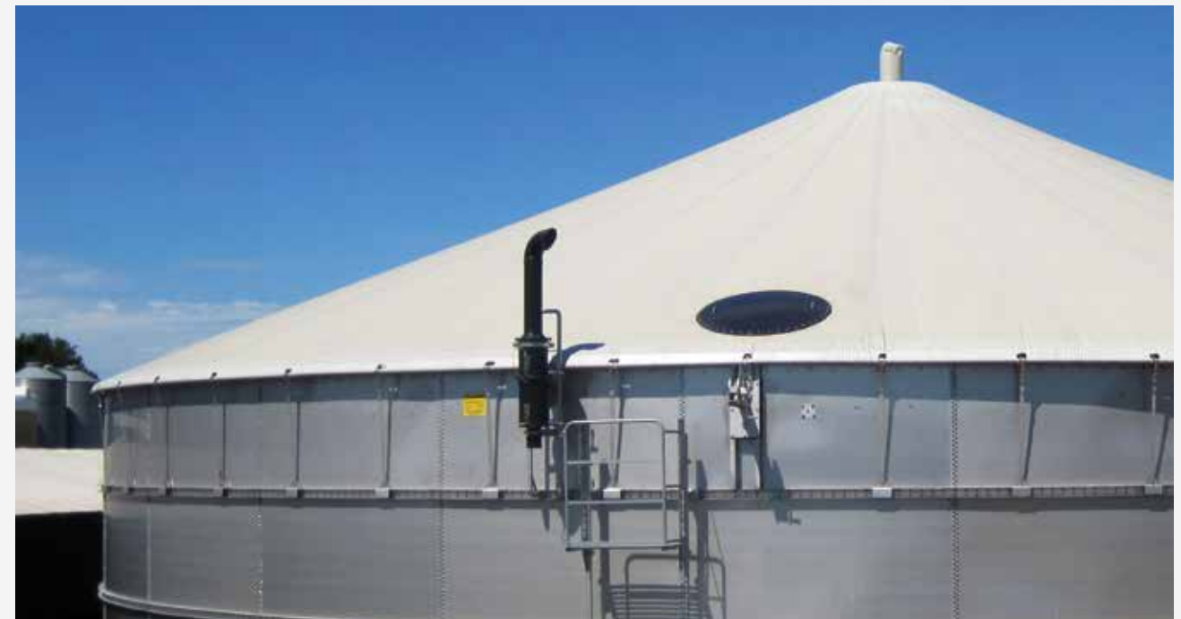
Biogasdach auf Edelstahlbehälter
