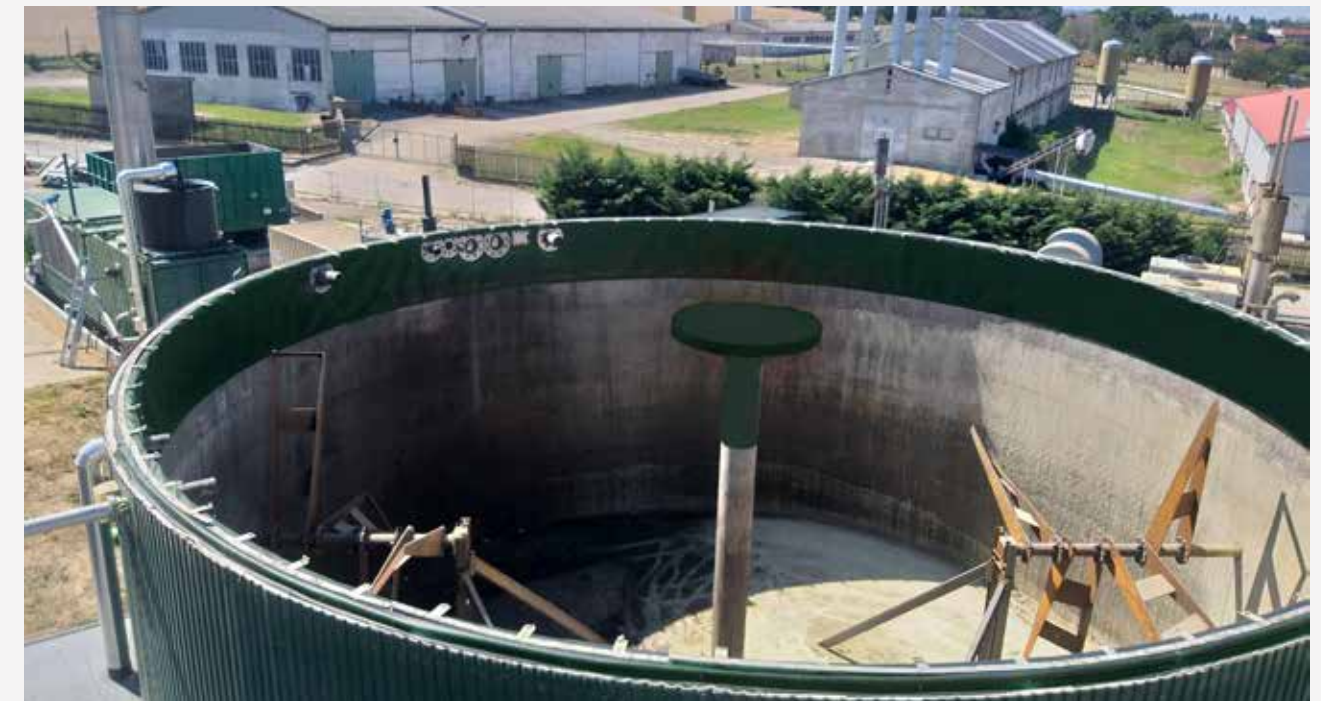
Wandsanierung 1 m mit Wanddurchdringungen
