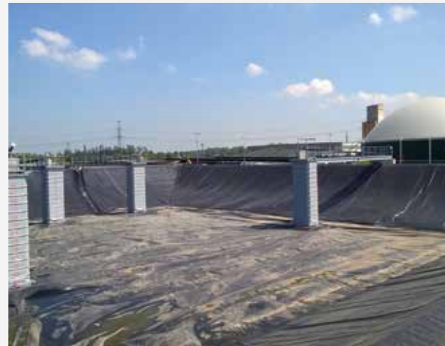
Lagune mit gasdichter Abdeckung 25.000 m 3
