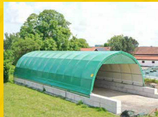
Rohrbogenhalle auf Betonblocksteinen
