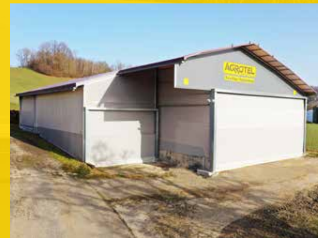
Lager- und Maschinenhalle mit textilen Toren
