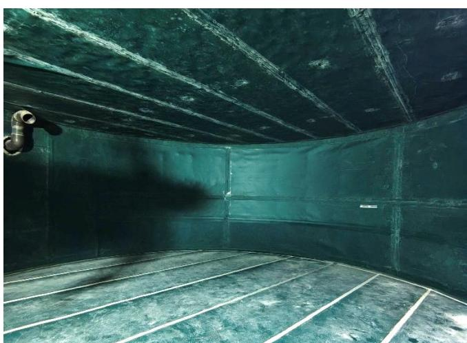
Boden-Decke-Wand-Sanierung im Behälterinneren mit SaniTarp®
