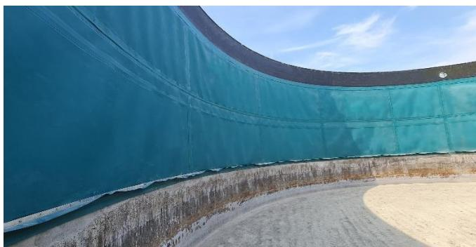
SaniTarp® Betonsanierung an Behälter-Innenwand inkl. Kronenschutz, Edelstahlklemmung und Überschweißungsbefestigung
