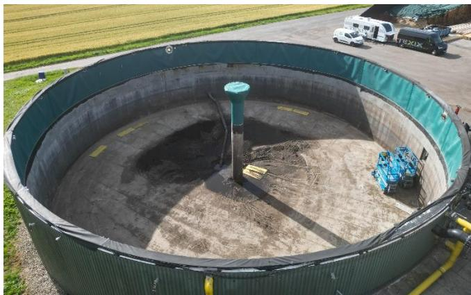
Biogasbehälter mit SaniTarp® Betonsanierung im oberen Drittel der Behälterwand und Mittelstütze (Gasraum)
