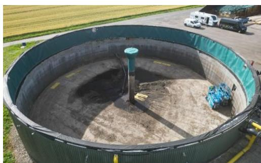
Réservoir de biogaz avec liner de rénovation du béton SaniTarp® sur le tiers supérieur de la paroi intérieure du réservoir et du poteau central
