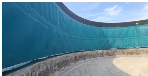
Liner de rénovation du béton SaniTarp® sur la paroi intérieure du réservoir, avec protection de la couronne, fixations en acier inoxydable et bandes de suroudage
