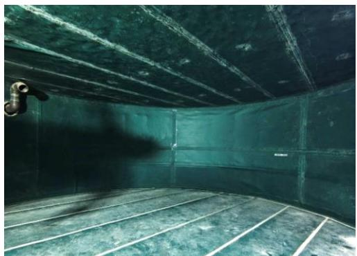
Rénovation intégrale de l'intérieur du réservoir avec SaniTarp®
