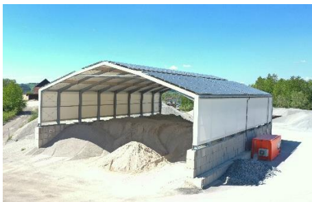
AGROTEL Satteldachhalle mit PV-Anlage als Baustofflager
