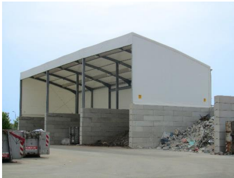
AGROTEL Pultdachhalle als Boxenüberdachung für Recyclingstoffe
