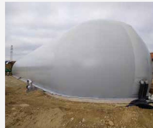
Magazyn podłużny 7.000m 3
