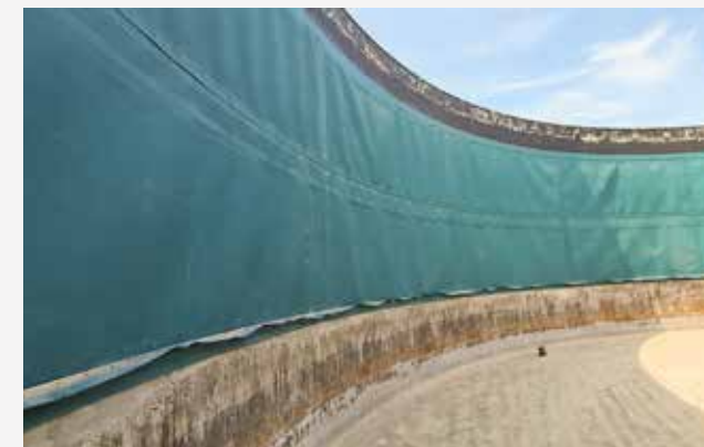
Renowacja ścian 5 m
