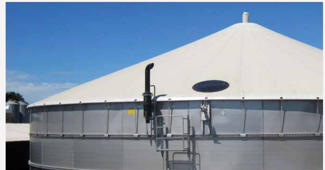
Dach z biogazu na zbiorniku ze stali nierdzewnej
