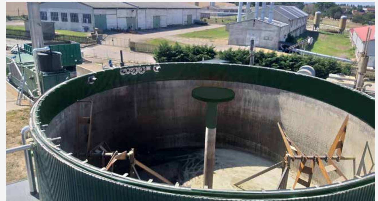
Renowacja ściany o długości 1 m wraz z przejściami przez ścianę
