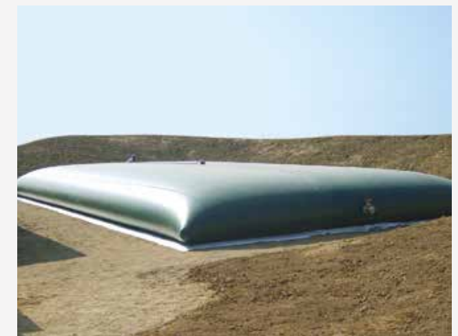
Zbiornik na wodę deszczową
