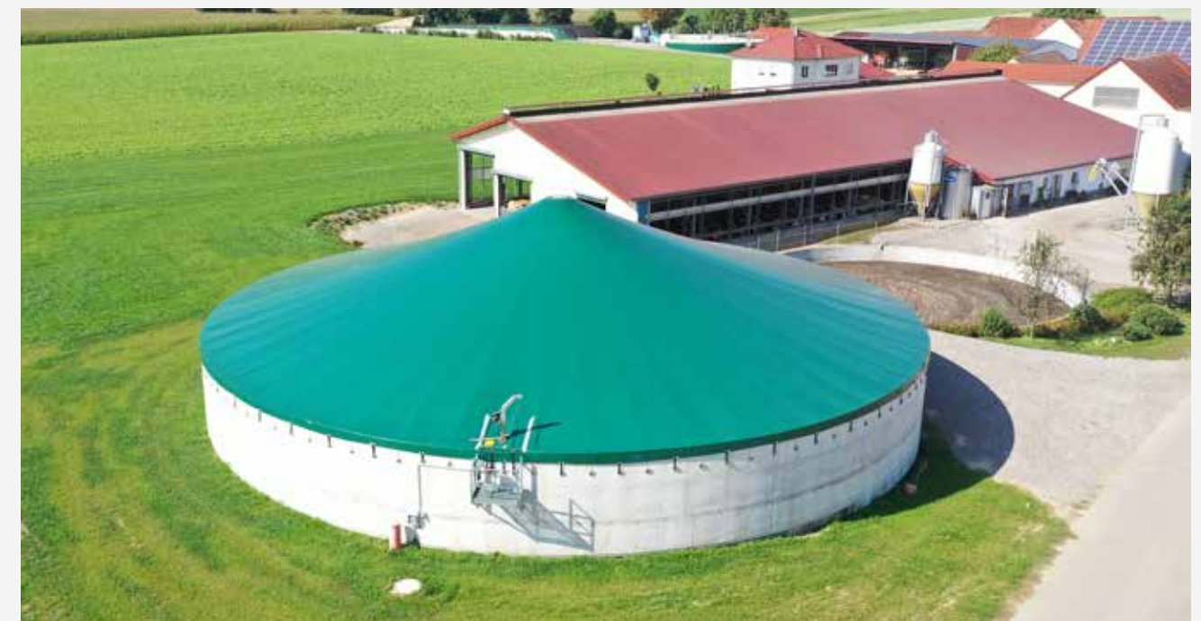
Zbiorniki z betonu lanego
