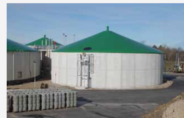
Dach z biogazu na zbiorniku żelbetowym
