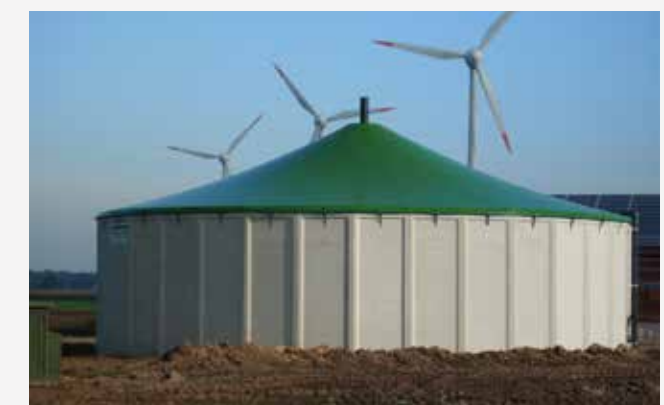
Dach z biogazu na zbiorniku z prefabrykatów betonowych
